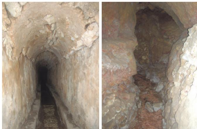
**Foto 2.** Aspecto de la galería. Izquierda: Tramo de mampostería con bóveda de medio punto y acequia central. Derecha: Sin refuerzo estructural.
